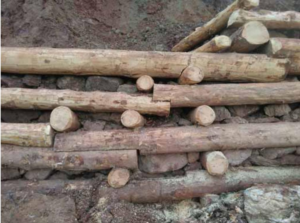
*En els punts d'unió de les dues subestructures es van fer encaixos per maximitzar els punts de suport entre ambdues i per tant enfortir la resistència global. Font: elaboració pròpia.*
