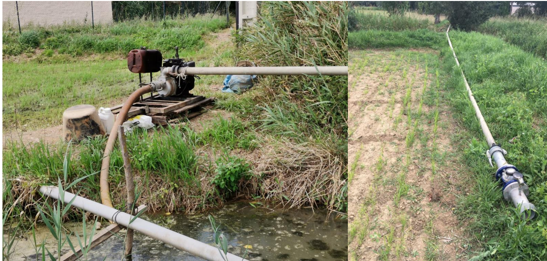
Figura 2.- Bombament i entrada d'aigua a la parcel·la d'assaig A.
