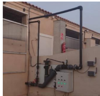
Figura 8. Sistema de dosificació d'àcid amb recirculació dels purins a l'interior de la nau. Font: Fertinagro Biotech, SL.
