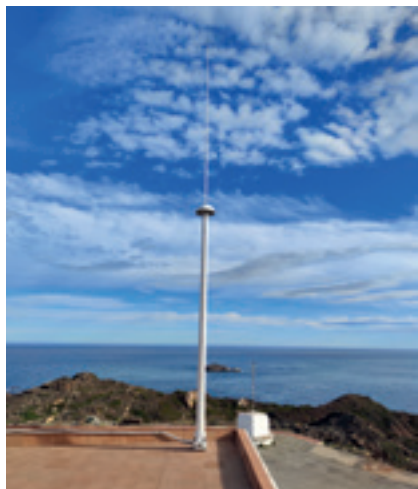
Detall del radar instal·lat al Cap de Creus
