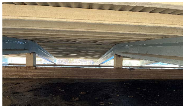
Figura 5. Estructura interna d'obra per a suport d'una coberta rígida de fibrociment en un dipòsit de purins. Font: DARPA.
