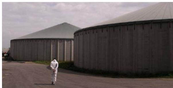
Figura 2. Dipòsits de purins amb coberta rígida. Font: IMPEL (Comparison Programme of IPPC Pig Farming Installations).
